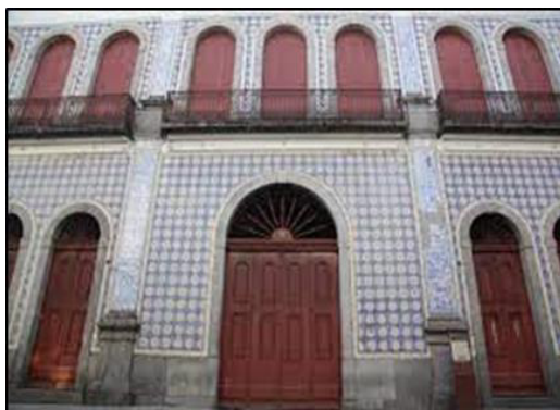
Figura 2.7.15-1: Casa da Frontaria Azulejada
